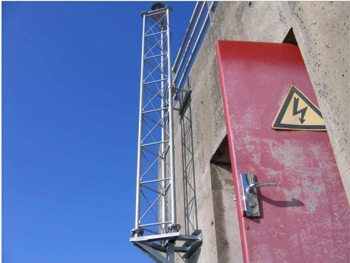
Fig. 2 : Implantation du pylône avec l'antenne GPS au sommet
