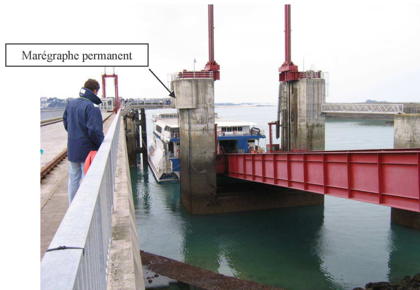
Rappel de la localisation du marégraphe dans le port de Saint-Malo
